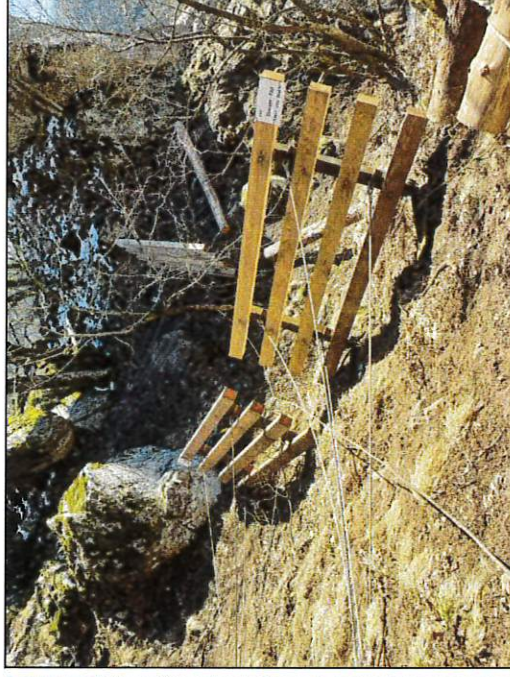
Figure 25 – Exemples de filets paravalanches à gauche (source : Geobrugg) et module rigide mixte acier-bois à droite (source : Avenir Protection)
