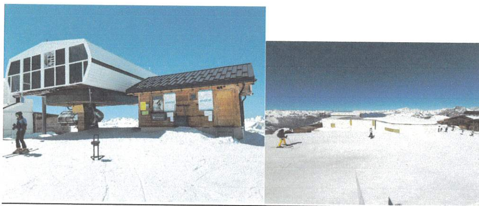
Gare d'arrivée actuelle du TSD Mont de la Chambre et garage à sièges masquant la vue sur le Mont-Blanc
