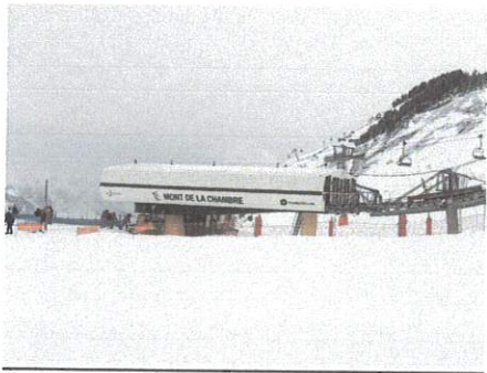
Gare de départ du TSD actuel du Mont de la Chambre
