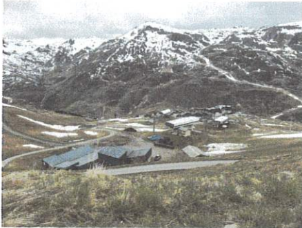
Emplacement de la future gare intermédiaire G2-G3 par rapport aux copropriétés les plus proches
