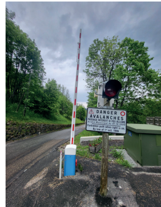
Barrière au Villard de Saint-Jean coupant la route lors du déclenchement d'une avalanche. PIDA routier
