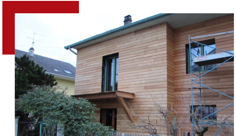
Ici, le balcon a été scié et refait en bois
