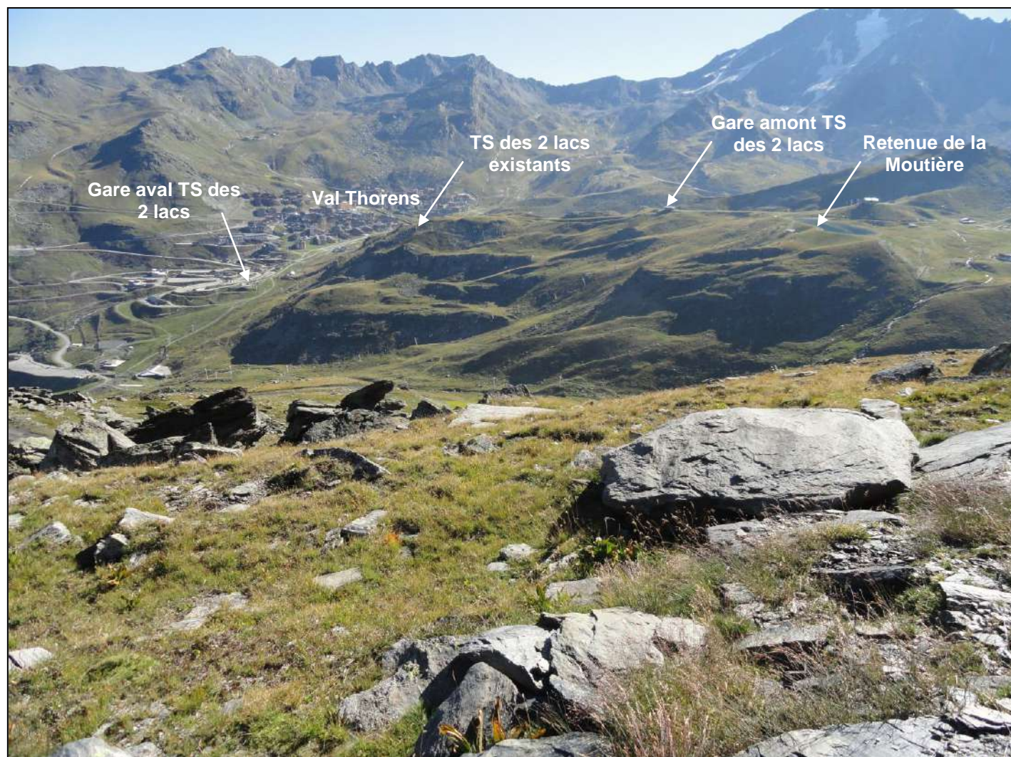
Vue de loin 2 : Vue de loin depuis le versant de Boismint
