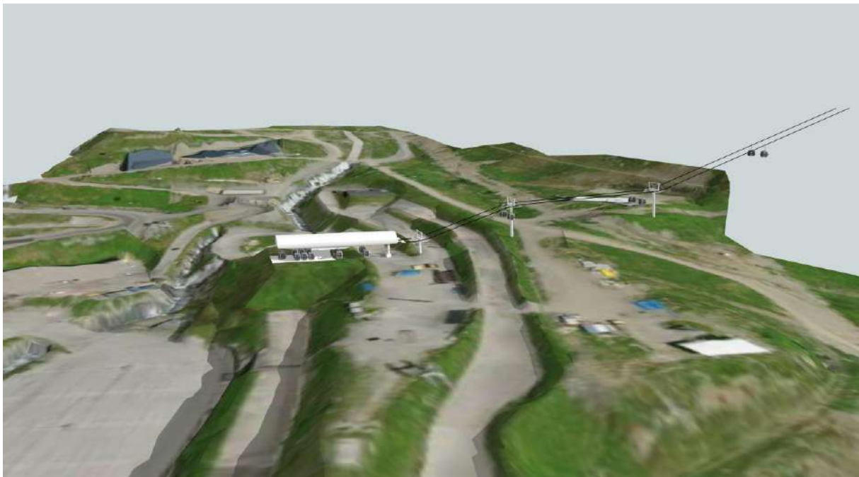
Insertion de la gare aval (©CNA 19-10-19)
