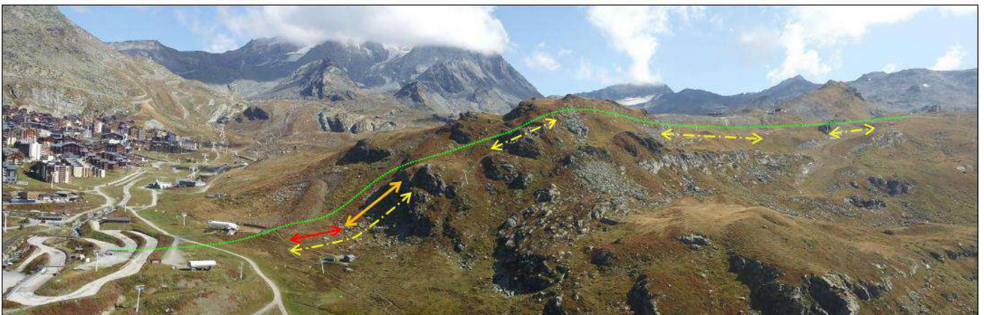
Figure 9: Vue générale de la ligne et de la zone à éviter pour l'implantation des pylônes (en rouge ≈ 40kPa, en orange ≈ 20/30kPa, en jaune phénomène de reptation)
