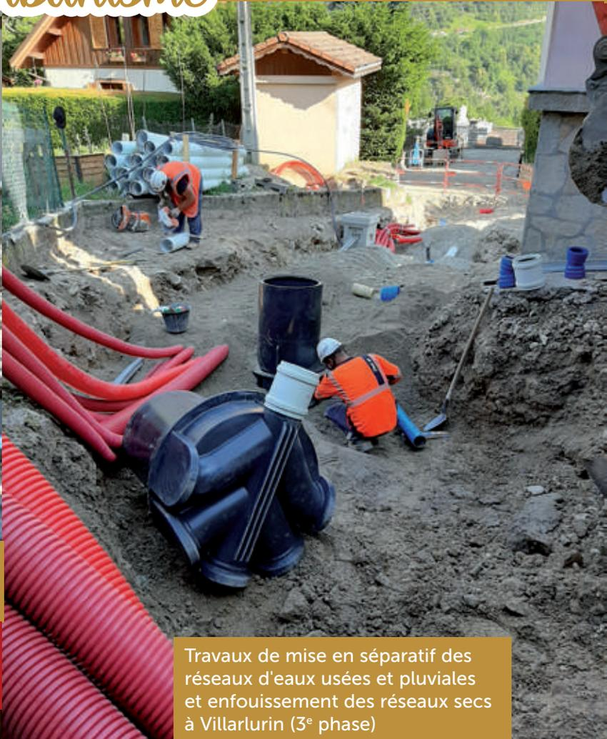
Travaux de mise en séparatif des réseaux d'eaux usées et pluviales et enfouissement des réseaux secs à Villarlurin (3<sup>e</sup> phase)
