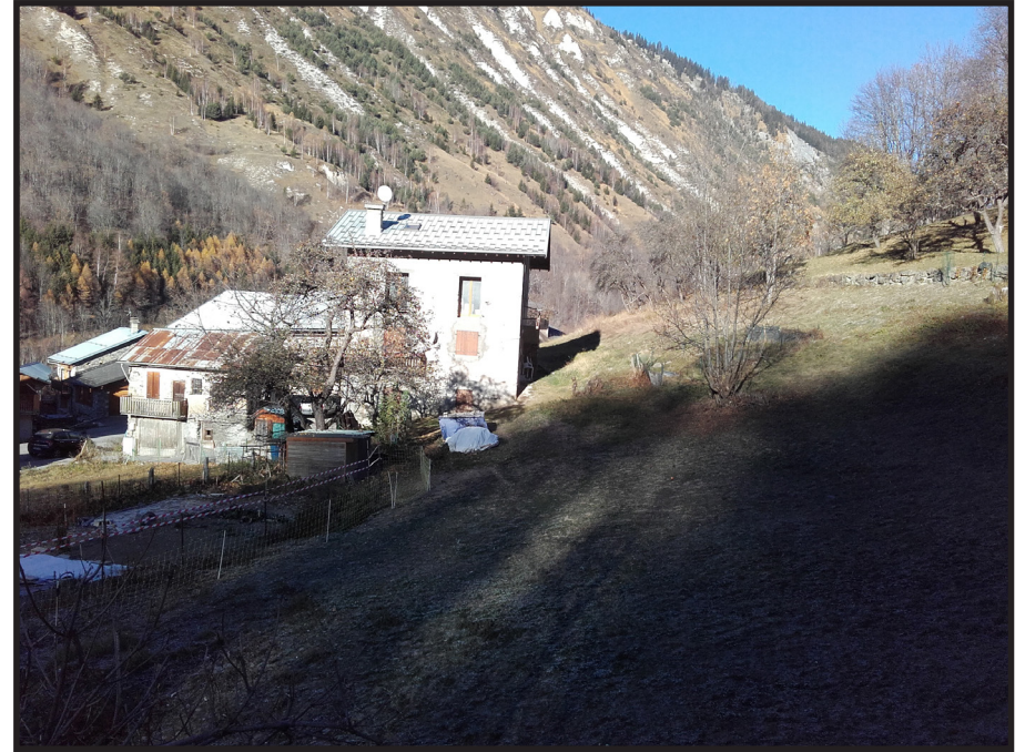
Zone de projet depuis le Sud du périmètre (vue vers le Nord)
