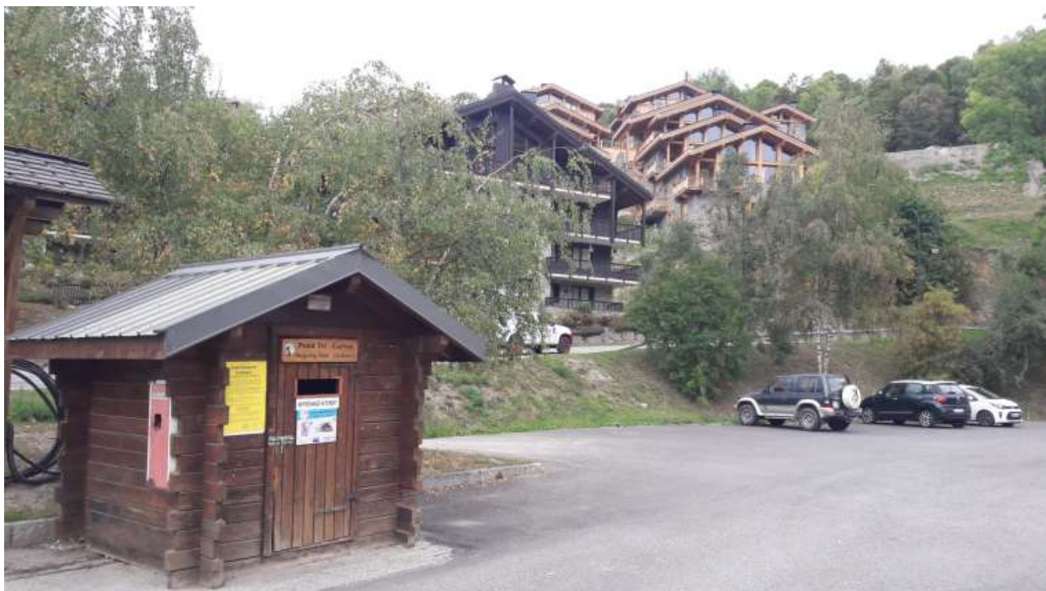
Affichage sur site n°4 Les Grangeraies
