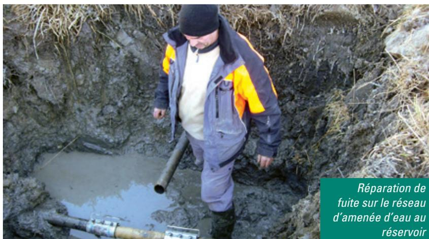
Réparation de fuite sur le réseau d'amenée d'eau au réservoir
