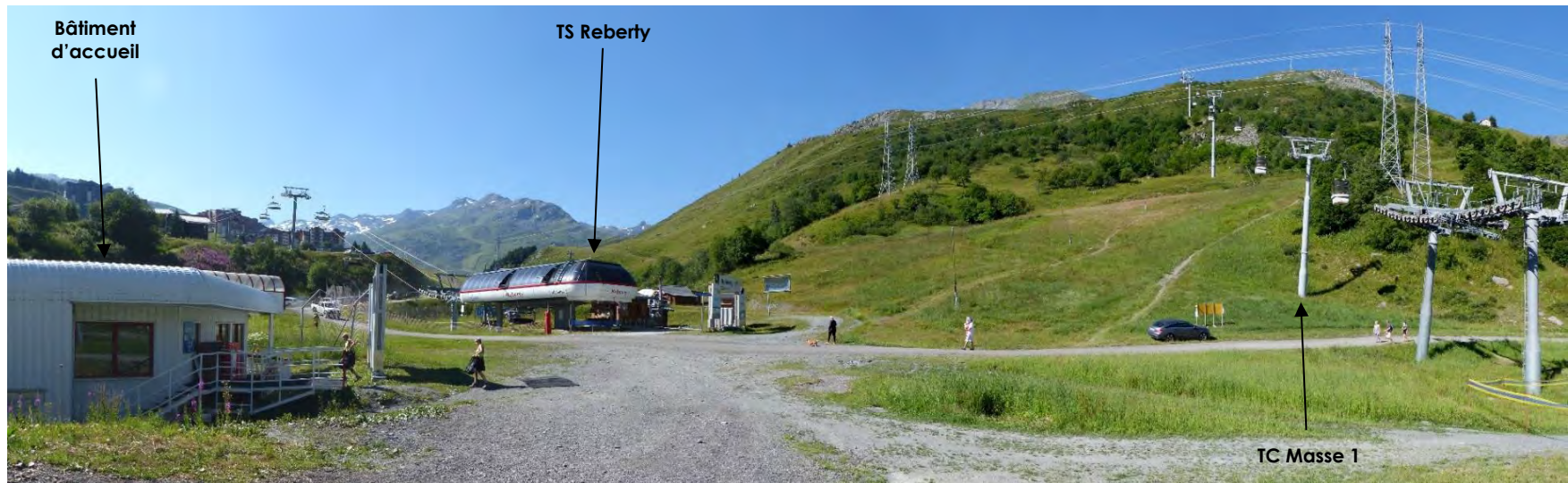
VR2 : Vue sur la zone de départ du projet depuis la gare existante de la TC de la Masse 1 : les éléments interférents sont nombreux et hétéroclites, perturbant la lecture du site (lignes électriques, signalétique, canons à neige, architecture des gares, etc.) (KARUM, 2018).
