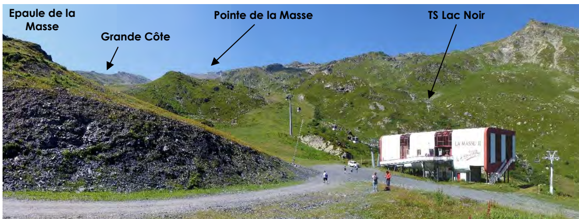
VR5 : Vue sur la gare de départ du second tronçon de la télécabine de la Masse (TC Masse 2). Localisée à l'arrière de l'épaule de la Masse et au fond de la combe des Enverses, son implantation est plutôt discrète malgré un habillage blanc impactant en saison estivale. L'axe de la remontée mécanique s'insère en revanche relativement bien dans la pente. La piste Covilli est davantage marquée par une texture herbacée lisse et un ton plus clair que le couvert naturel (KARUM, 2018).
