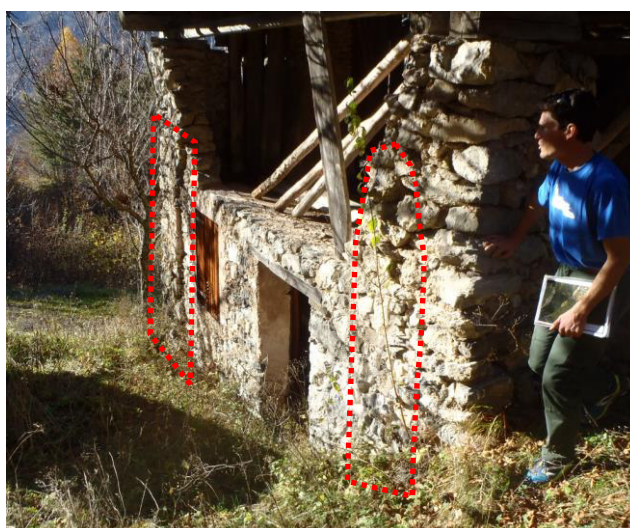
Figure 15 : bâtiment fissuré
