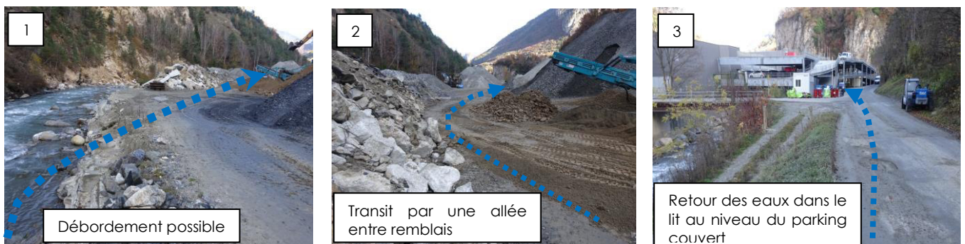
Figure 7 : parcours des débordements depuis l'amont de la plateforme de traitement de matériaux jusqu'au Super U
