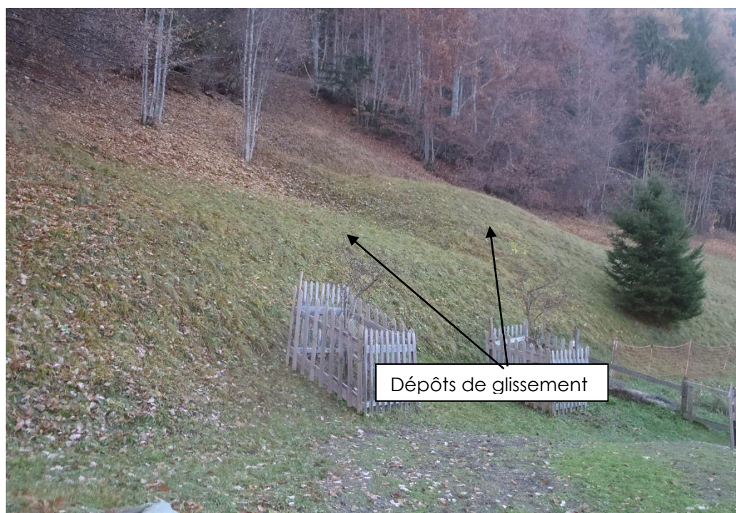
Figure 16 : signes de glissement
