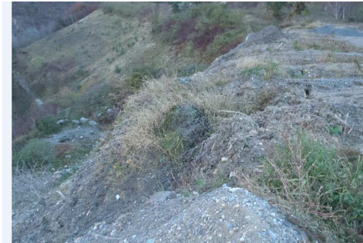
Figure 10 : remblais en glissement
