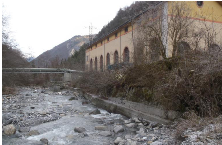
Figure 11 : Lit du Dorons des Bellevilles au droit de la centrale
