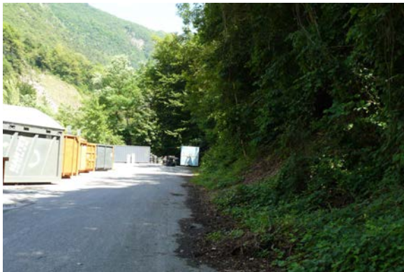
La berge du Doron de Bozel, enrochée et sans ripisylve
