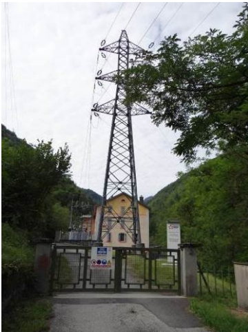
Centrale électrique et pylône
