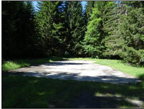
Photo 49 : Dalle béton en forêt de Longefrasse
